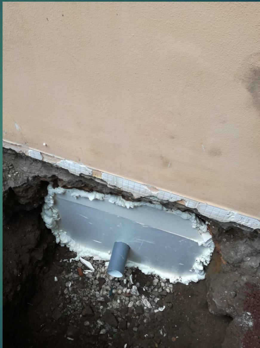
Il peribattenti con membrani in feltro e feltro di bitume, secondo la norma UNI EN 12053, è stato installato nel 2021 -
